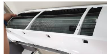
ไม่มีจุดถอดแยกชิ้นส่วนที่ด้านหลัง ไม่ต้องใช้เครื่องมือพิเศษ
