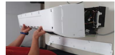
ไม่มีจุดถอดแยกชิ้นส่วนที่ด้านหลัง ไม่ต้องใช้เครื่องมือพิเศษ
